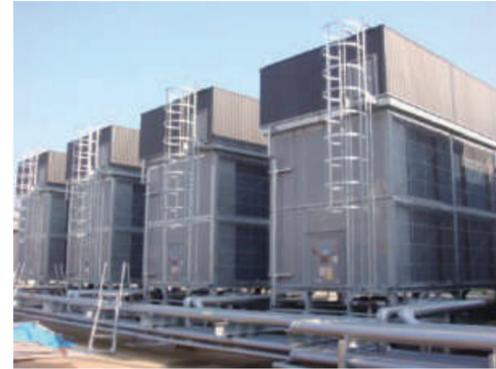
コージェネのエンジンの冷却水には、エンジン本体の冷却(ジャケット系)と空気冷却器+潤滑油冷却器の冷却(クーラー系)の2系統があります。中大型機では2系統を別々に冷却し、小型機ではエンジン迄は1系統とし、エンジン内部で2系統に分流しています。
