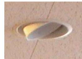
360°回転する中ノズル。垂直方向で気流角度を約40°まで可変可能。
