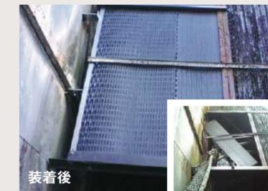
充てん材にエリミネータを装着することで、循環水の飛散、落下を軽減し大幅な省エネにもつながります。型式によっては対応できない場合がございます。
