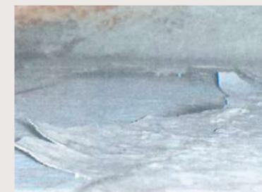
冷却水などの影響で下部水槽の表面塗料が剥離すると、漏水の原因となり環境汚染や水道料金の上昇につながります。
