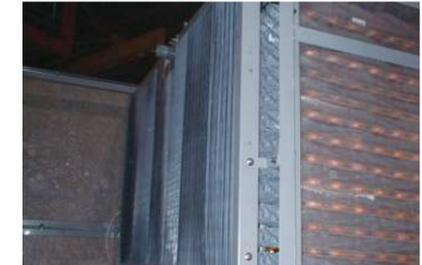
ファンによるキャリーオーバー防止のため塔内にエリミネータを設置することができます。風量を不足させないよう、状況に合わせて設計します。
