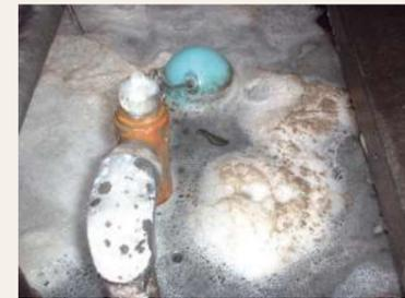
冷却塔の設置環境や運転水により濃縮された水が冷却塔各部材に散水され冷却能力低下や各部材劣化を早めてしまいます。
