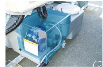
循環水にスライム・スケール・腐食を防止し、レジオネラ菌対策ができる薬品を自動的に注入することで、理想的な水処理が可能となります。
