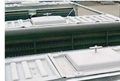
異物の混入を防ぎます。また遮光性も兼ねるのでスライムの発生を抑制します。歩廊兼用のため、塔上作業が安全に行えます。FRPまたは鋼板製。
