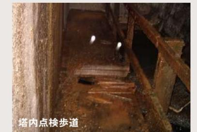
冷却水が充滿するクーリングタワー内部は、経年劣化やサビにより、塔内点検歩道や鉄部に穴が開くなど耐久性が著しく低下します。
