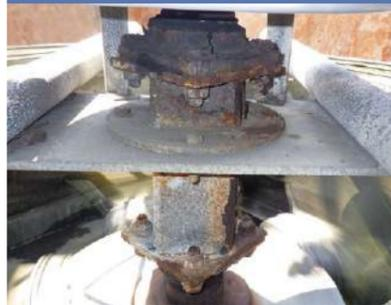
腐食が進行し、不良となったファン側軸受けベアリング。
