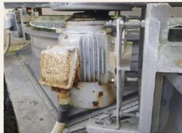
ベアリングの劣化・軸磨耗が考えられます。モーターケースが腐食している場合は、強度不足・絶縁不良や振動値上昇などが考えられます。
