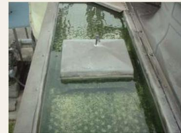
直射日光によるスライムの発生や、剥離したシリカなどにより上部水槽の散水穴が塞がれ冷却能力が低下します。
