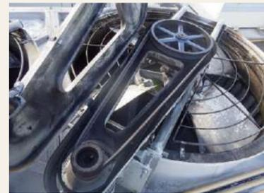
Vベルトが緩んだり、ベルトの摩耗により翼車の回転不足やVベルトの脱落を招き、性能不足や消費電力の無駄が発生します。
