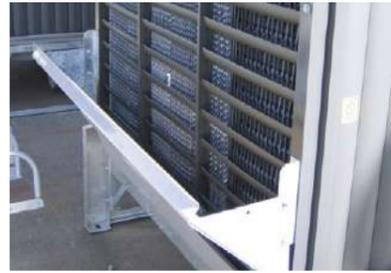
クーリングタワーの外部に飛散した循環水を塔内に戻す働きをします。
