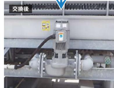
ベアリング、パッキンの交換、分解整備を行います。劣化が酷い場合は、新品と交換します。
