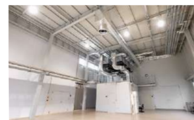
第2気流試験施設 高天井・高壁取付器具の到達性能を測定します。
