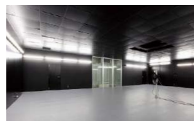
第1気流試験施設 複数の制気口による気流干渉や、ペリメーター負荷変動による温熱環境の測定が可能です。
